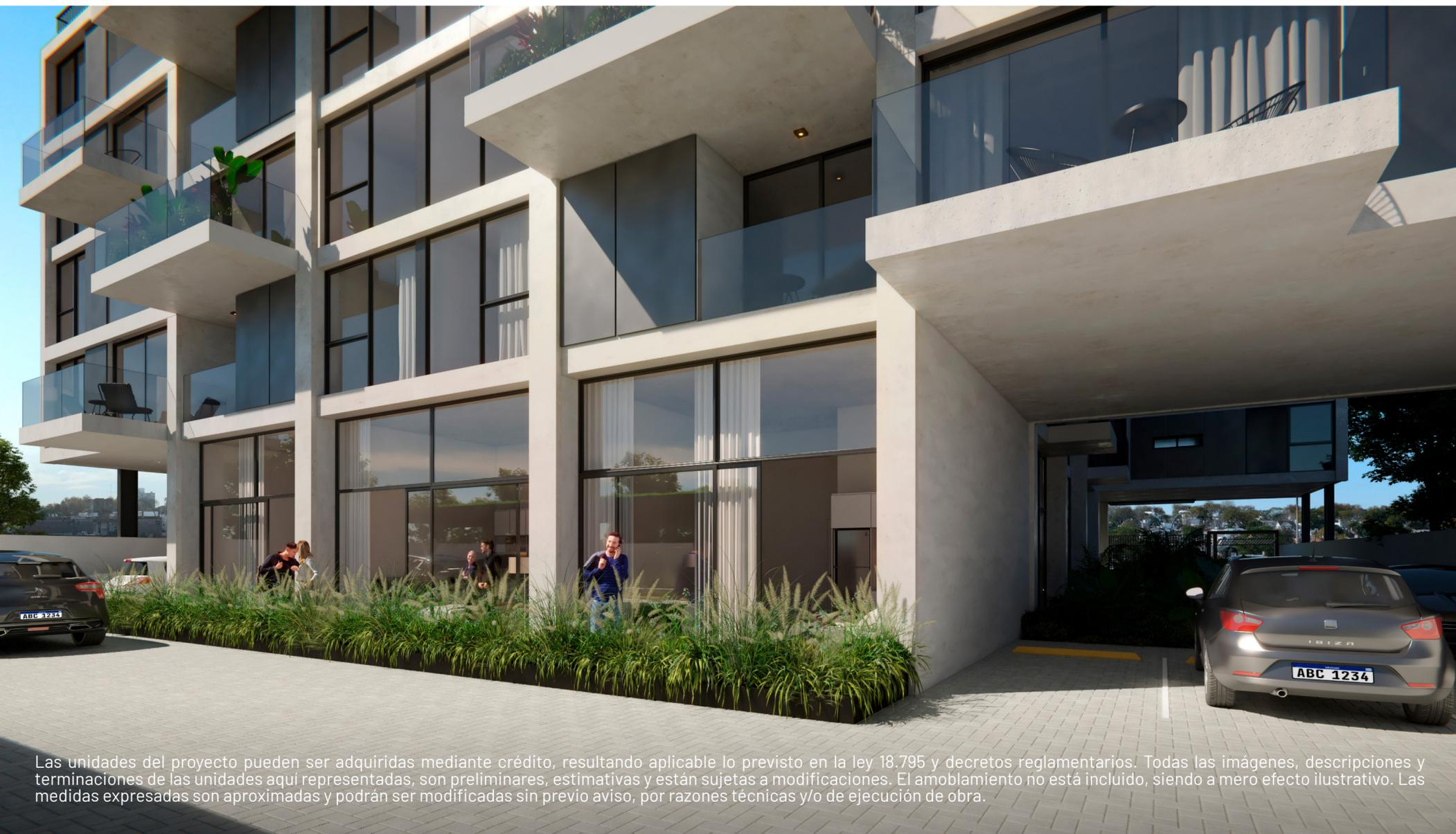
El basamento, la torre y el remate del edificio están proyectados como una unidad arquitectónica, que se construye a partir de una estructura de pilares y vigas de hormigón, que acompaña la geometría del edificio en todo su desarrollo. Es así que se logra que todas las fachadas tengan un tratamiento integral en el que priman materiales de bajo o nulo mantenimiento.
